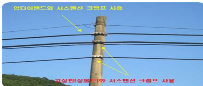
[그림 3-3] 한 개 통과 통신주에 2~4조 광케이블 고정(예시)
