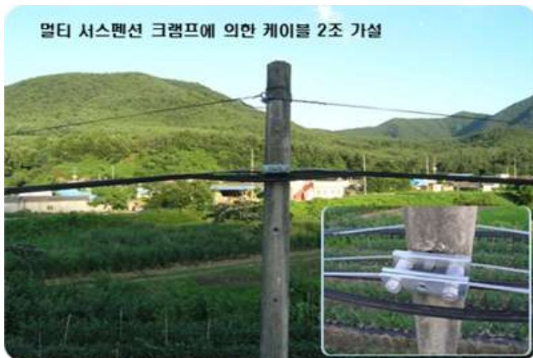
[그림 3-6] 멀티 서스펜션 크램프에 의한 케이블 고정
