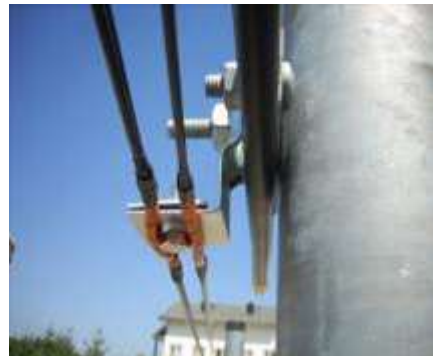
[그림 3-10] 기설치된 서스펜션에 L형1볼트 서스펜션 크램프 취부
