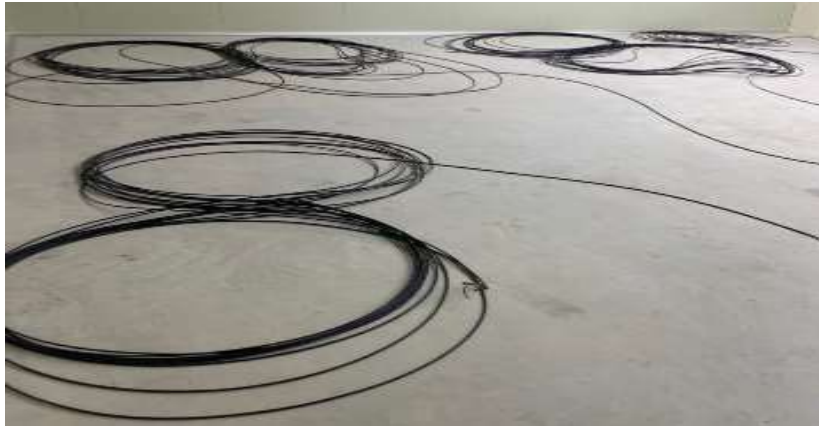
[그림 4-4] 8자형 광케이블 감기(예시)
