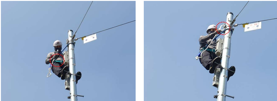
[그림 2-6] 안전대 착용 및 고정(예시)
