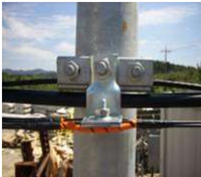
[그림 3-10] 기설치된 서스펜션에 L형1볼트 서스펜션 크램프 취부
